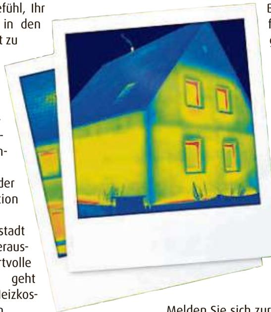
Blau steht dabei für kalt und gut gedämmt, rote Flächen hingegen kennzeichnen hohen Wärmeverlust. Und sogar feuchte Stellen am Haus lassen sich so aufspüren.
